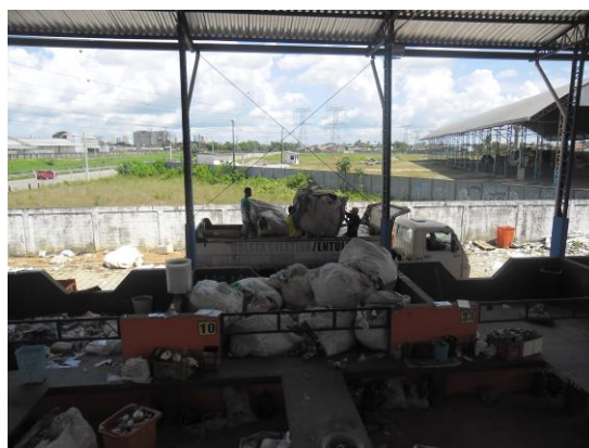
Imagem 41 – Descarga de material para as baias de triagem – Belém
