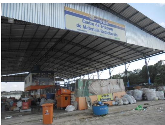
Imagem 40 – Galpão de triagem utilizado pela ACCSB – Belém
