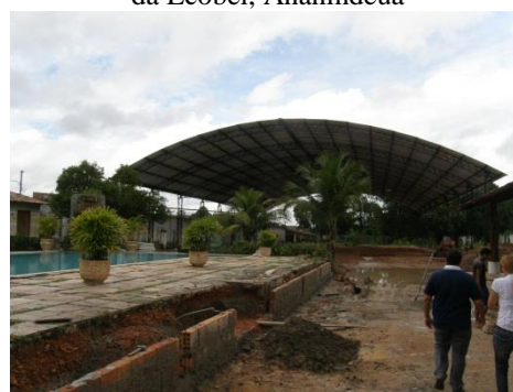
Imagem 50 – Construção de novo centro de triagem da Ecobel, Ananindeua
